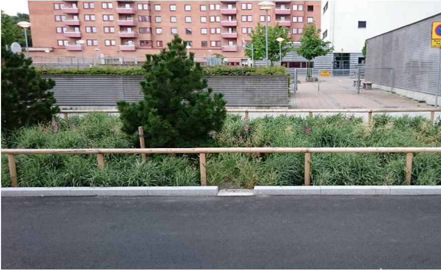
Figur 8: Nedsänkt växtbädd med inlopp genom nedsänkt kantssten. (sigmacivil.se)
